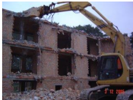
een flatgebouw en een brug worden gesloopt
