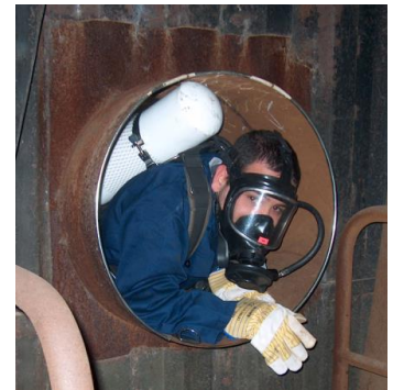
- toegang tot een besloten ruimte
