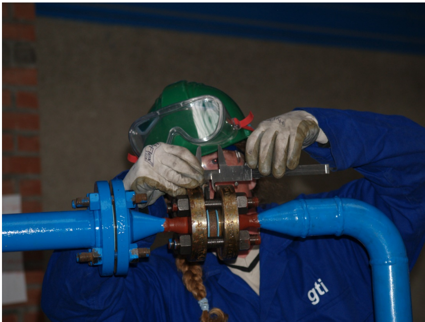
Afb. 38: Meten met de schuifmaat in uitvoering.
